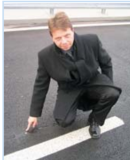
Tomáš Mrázek ukazuje trysku automatického protínámrazového systému.
