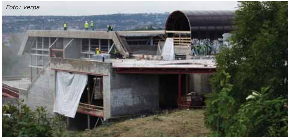
Dělníci začali připravovat plavecký areál Šutka k dalším stavebním pracem
