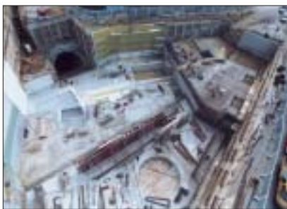
Výstavba vestibulů stanice metra Kobylisy.
