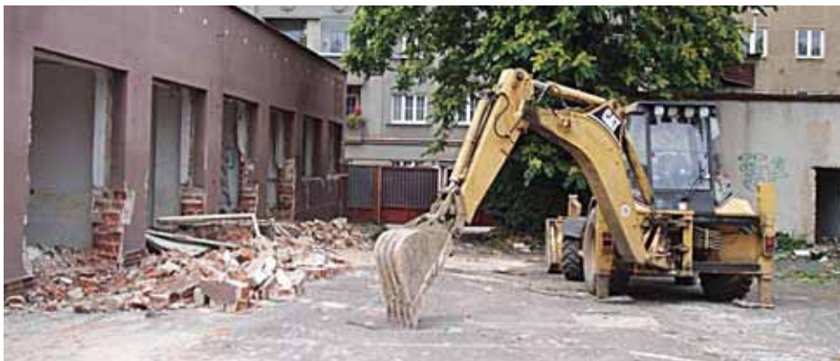
Demolici objektu odstartovaly v polovině srpna bagry
