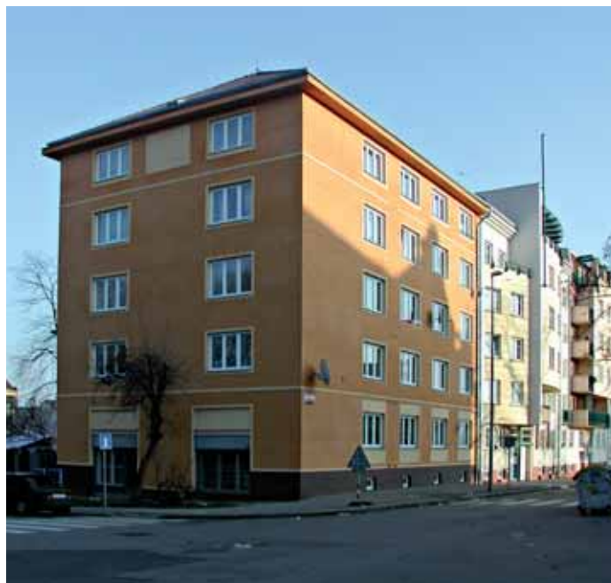
Pěknou fasádou a rovněž novými okny se může pochlubit dům v libeňské ulici Na Korábě.
