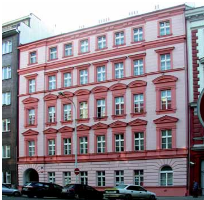
Dům v Peckově ulici má novou fasádu, okna a opravenou střechu.
