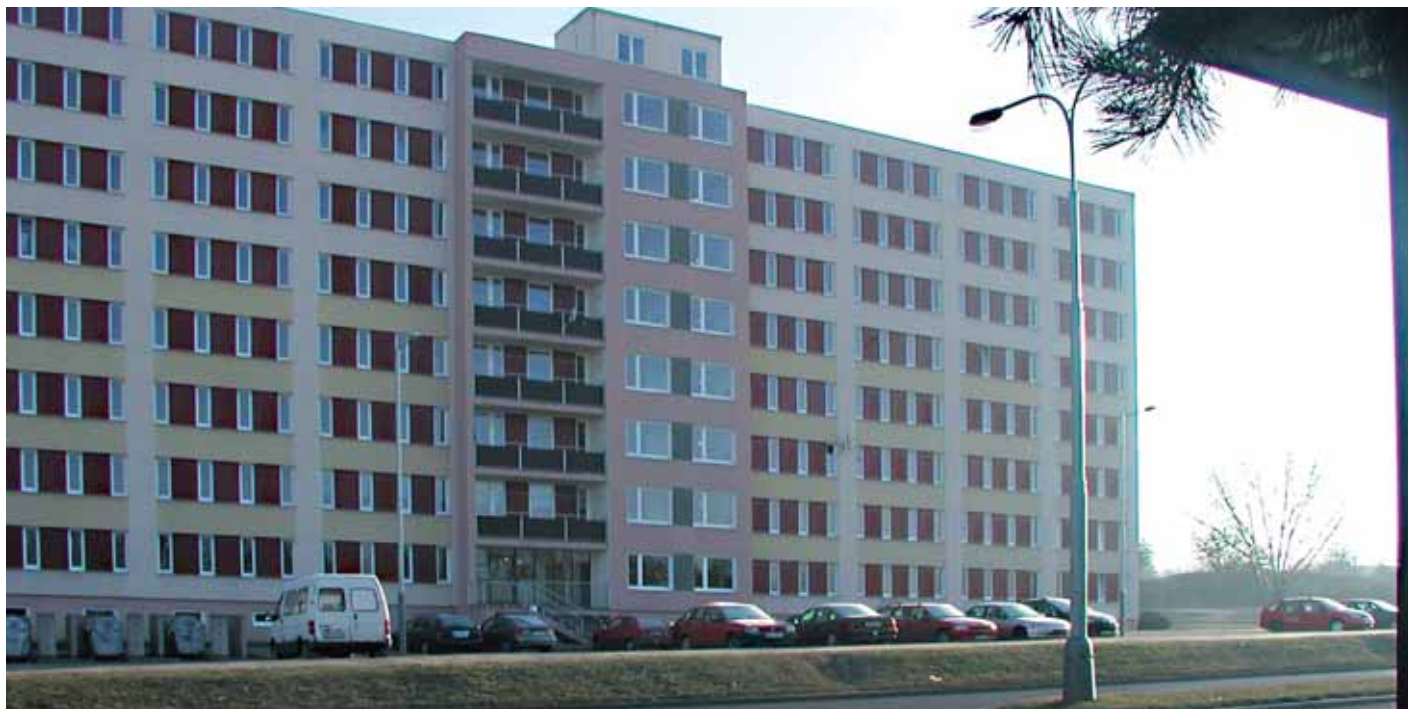
Panelový dům v Čimické ulici č. p. 767 - 769 v Bohnicích se dočkal celkové výměny oken.
