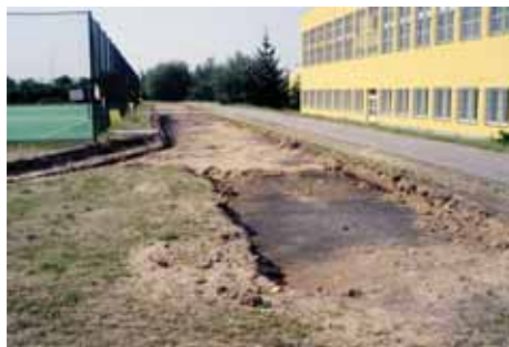
Rovněž v Glowackého ulici se pracuje na novém atletickém oválu
