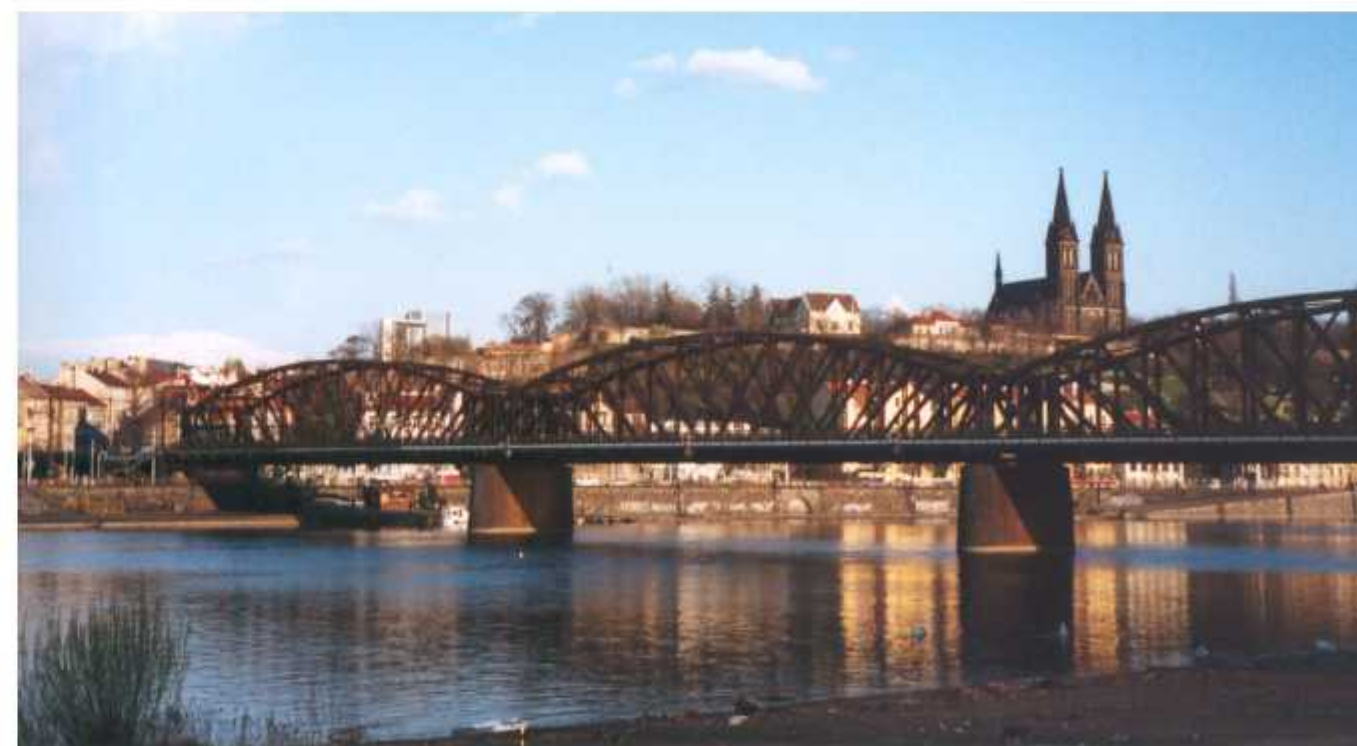
Obr. 2: vyšehradský železniční most
