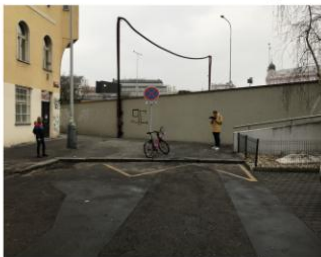
opěrná zídka nájezdu na magistrálu v ul. Ke Štvanici, pohled z ul. Pobřežní (v pozadí hotel Opera)
