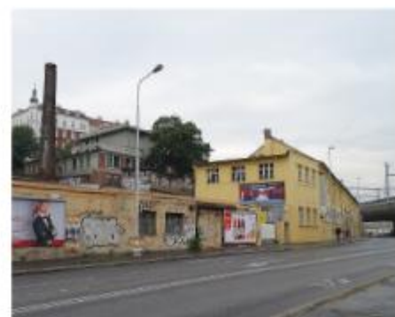
Areál drážní měřírny v ul. Husitská
