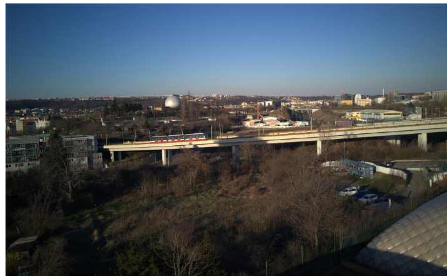
výhled východním směrem březen/2019
